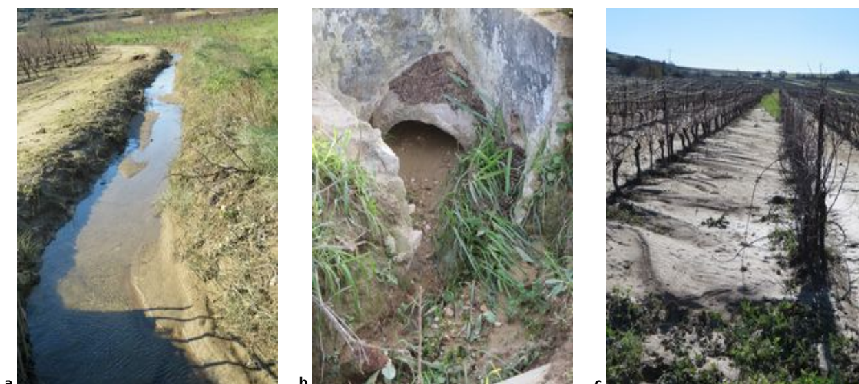
Figure 25. Illustration des nombreux dépôts sur le bassin de Roujan après une crue importante : a) fossé situé dans la zone basse de Roujan comblé avec environ 80 cm de sédiments ; b) passage busé sous chemin bouché par les sédiments déposés ; c) dépôt, au sein d'une parcelle de vigne, de sédiments provenant de parcelles amont plus pentues ; d) dépôt, en bas d'une parcelle de vigne, favorisé par la présence de végétation naturelle au niveau d'une zone située en amont immédiat d'un mur de terrassement. Photographies de D. Raclot (09/12/2014).
