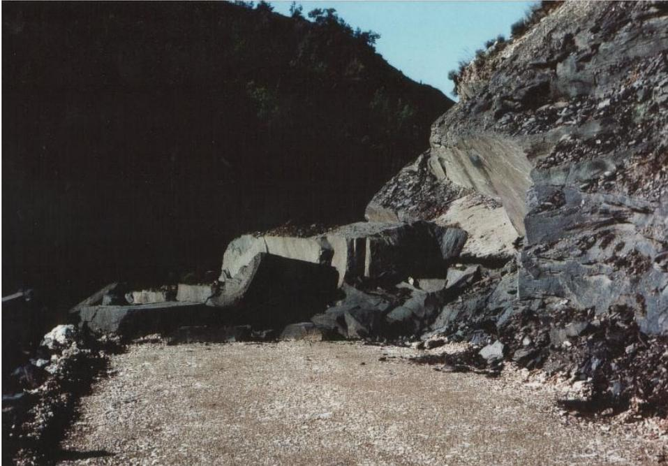
**Photo 1. Ecoulement marneux barrant le chemin d'accès au Laval (1987) : il s'est produit quelques jours avant la photo, la marne n'est pas encore altérée.**
