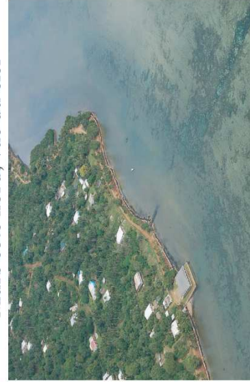
Murs côte nord, vue du ciel
