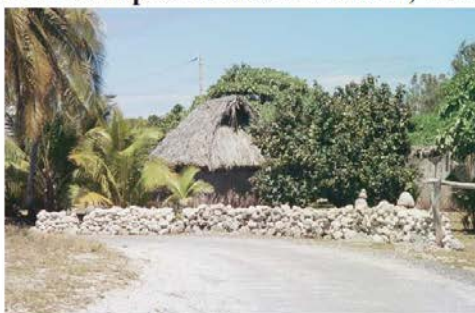
Muret composé de blocs de corail, Wallis
