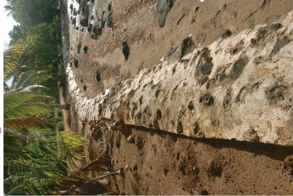
Ouvrage bien construit
