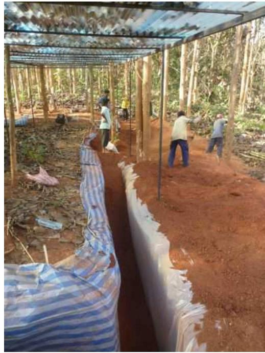
**Photo 14:** Tranchées en cours de réalisation (2.5 m de profondeur): mise en place des bâches d'étanchéités et rebouchages après collecte de racines
