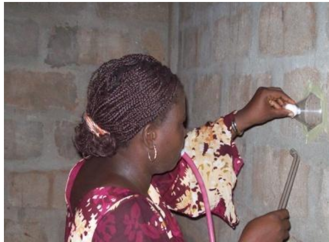
Photo 2 : Réalisation du test en cône sur un mur
