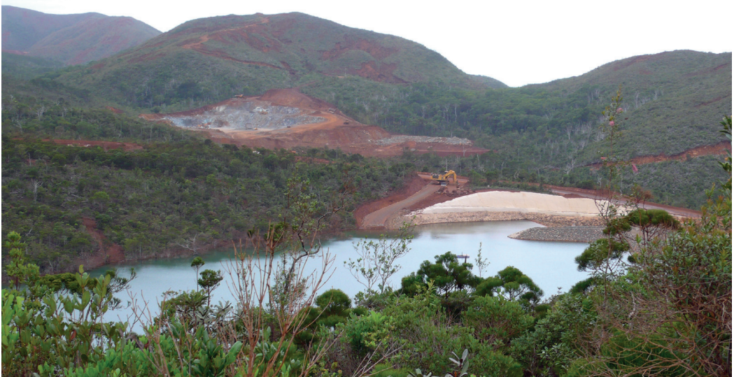
Bassin de sédimentation mis en place par Vale – © IRD
