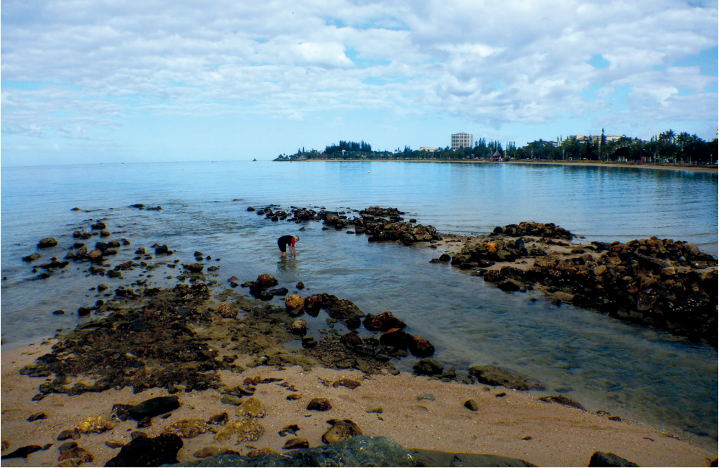
Rejet dans le milieu naturel des eaux de la STEP de l'Hippodrome, à Nouméa – © P.FEY
