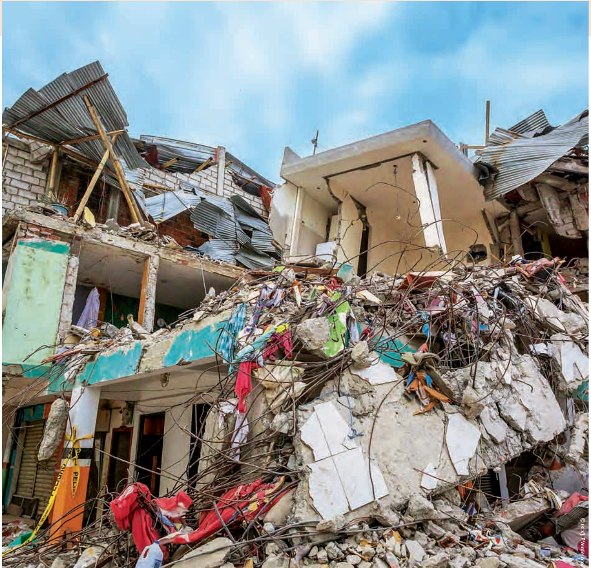
Après le séisme, Équateur.
