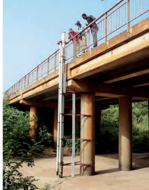
Dispositif de mesure de hauteur d'eau, Bénin.
