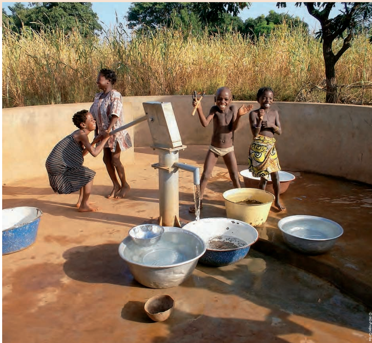
Forage équipé d'une pompe, Bénin.
