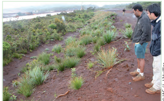
Figure 6.56 : Talus de piste recouverte de topsoil par transfert direct (Goro). Après trois ans, on constate l'implantation spontanée de nombreuses Cyperaceae et de quelques espèces ligneuses.
