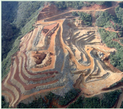
Figure 6.48 : Verse avec topsoil étalé sur les banquettes (verse Newco, Kouaoua).
