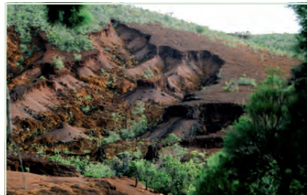
Figure 3.145 : Ravine d'érosion remontante (lavaka).
