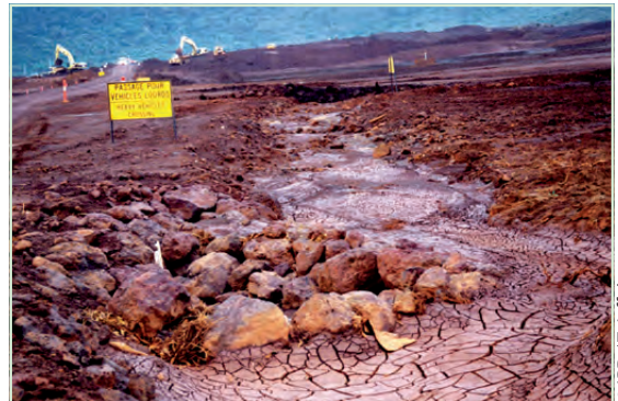
Figure 1.9 : Zone de décapage à Goro.
