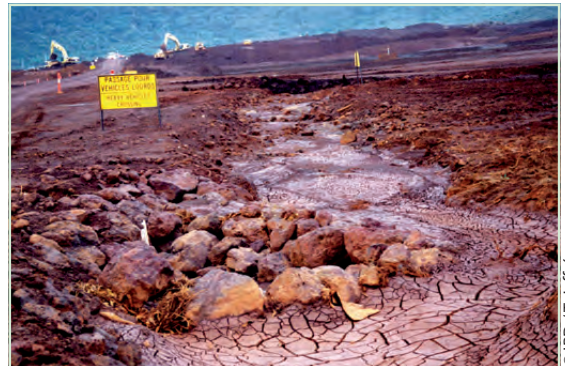
Figure 1.9 : Zone de décapage à Goro.
