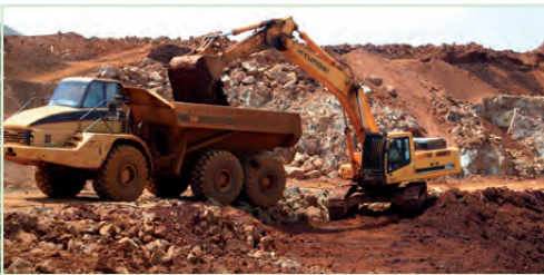
Figure 2.11 : Évacuation des latérites de surface pour accéder au minerai saprolitique (Tontouta).
