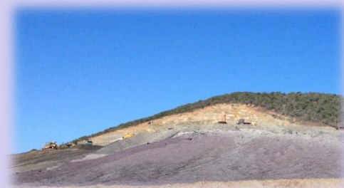
Dépôt de scories de l'usine KNS
