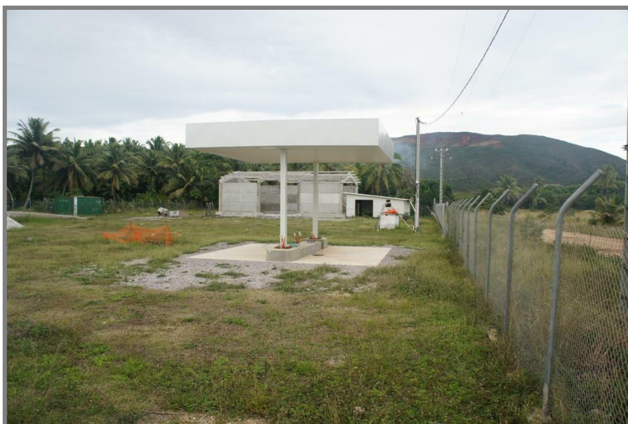
(Chantier de la station d'essence Poum, Source: Matthias Kowasch (2012))
