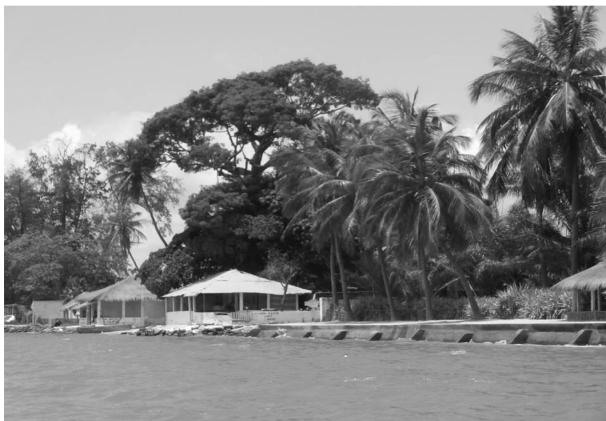
Figure 4. Mur protégeant les maisons contre l'érosion côtière, Carabane, juillet 2014 (embouchure du fleuve Casamance, rive gauche)
