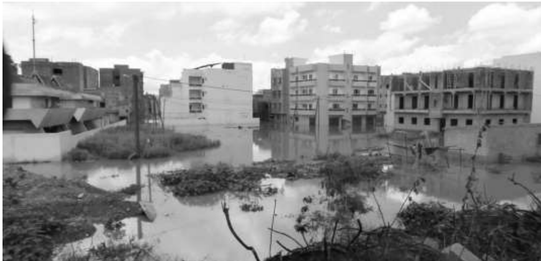
Figure 4 : les immeubles construits au début des années 2010 sur les terrains de la Foire de Dakar : une nouvelle Venise ?
