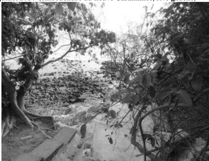
Figure 11. Guinée Bissau : Varela : malgré un soubassement rocheux, le lieu saint consacré à El Hadj Omar est menacé par l'érosion côtière (mai 2014)
