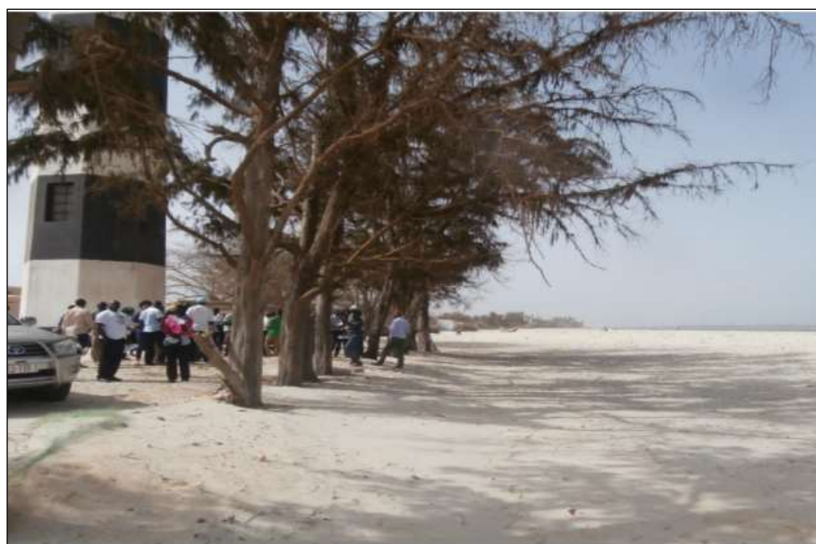
Figure 16 : mur de protection du phare de Gandiol, au village de Pilote Barre, attaqué par la houle (mars 2015) : les filaos en arrière du mur sont déjà en grande partie déchaussés ; des travaux de remblaiement effectués par la Direction de l'Environnement du Sénégal ont heureusement, début 2016, permis de protéger ce site et le village ; photo du bas prise en mai 2016
