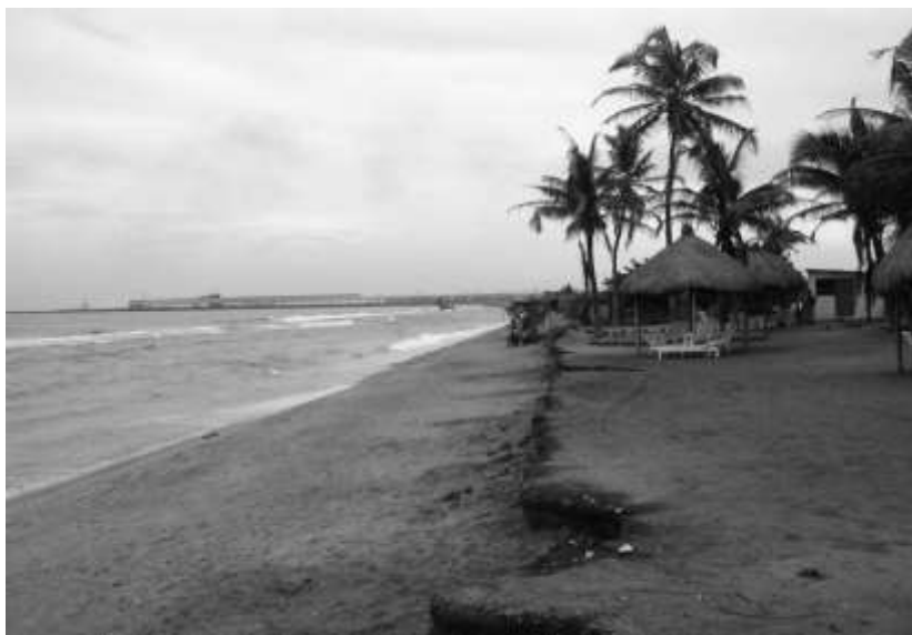
Figure 4 : équipements touristiques en passe d'être détruits à Lomé (Togo)
