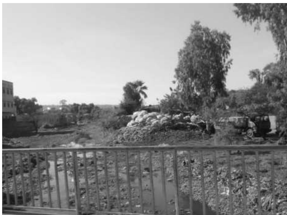
Figure 10. Photo prise fin novembre 2013 montrant l'état du lit du cours d'eau est
