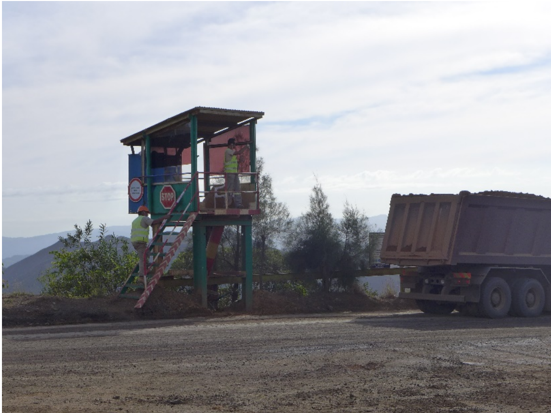
Figure 9 : Le « perchoir », zone de vérification des teneurs, avant que le minerai descende vers le bord de mer.
