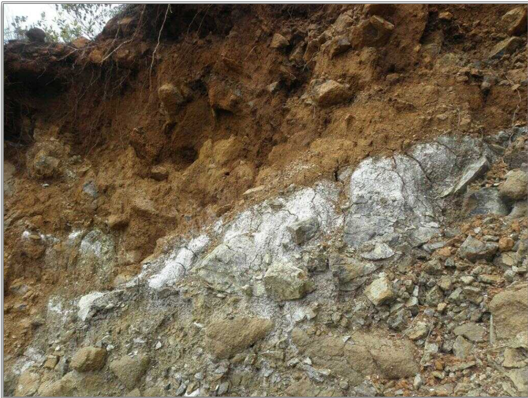
Illustration 137 : Mottes de terres blanches soulignant la zone de transition entre la saprolite et la latérite (Route de Saint-Gabriel).
