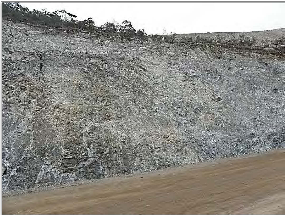
Illustration 43 : Vue générale de la zone serpentinisée affectant la partie sud-occidentale du massif du Koniambo.
