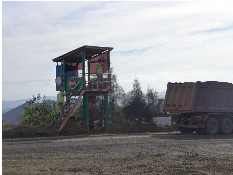
Le « perchoir » : zone de vérification des teneurs, avant que le minerai ne descende vers le bord de mer
