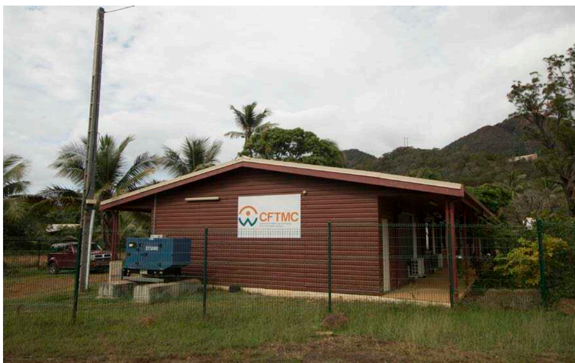
Centre de formation aux techniques de la mine et des carrières de Poro
