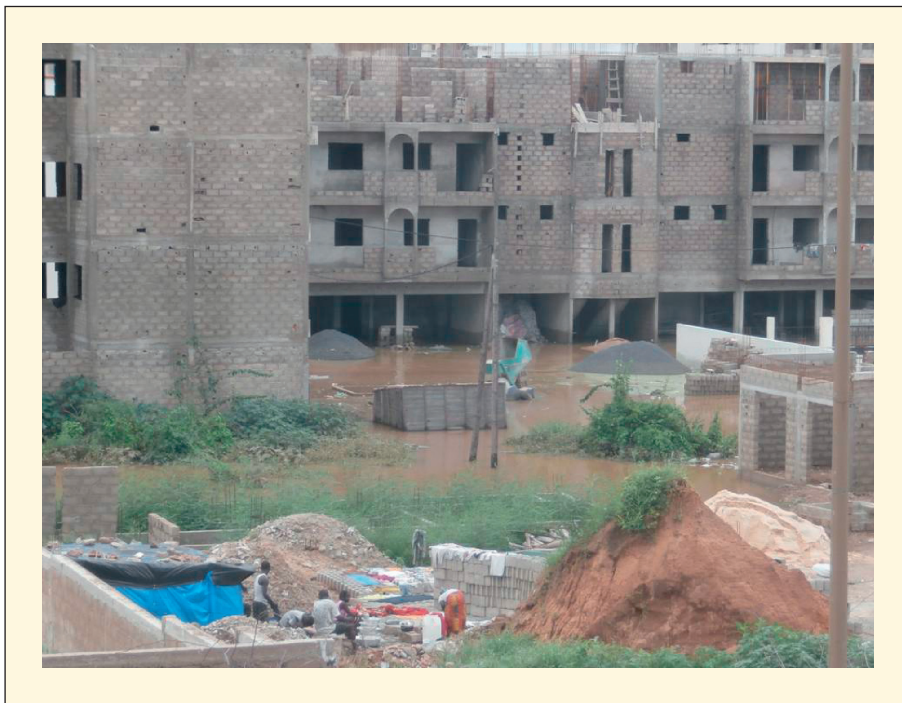
Figure 5. Dakar, 27 août 2012 : des quartiers encore en construction mais déjà inondés.
