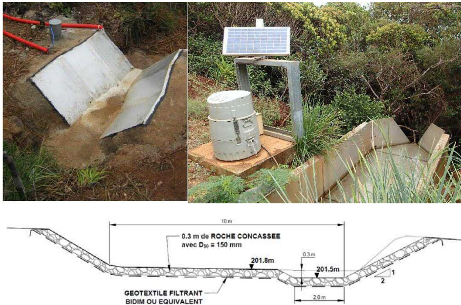
Figure 21 : Exemples de stations limnimétriques selon l'importance du creek (source Golder)
