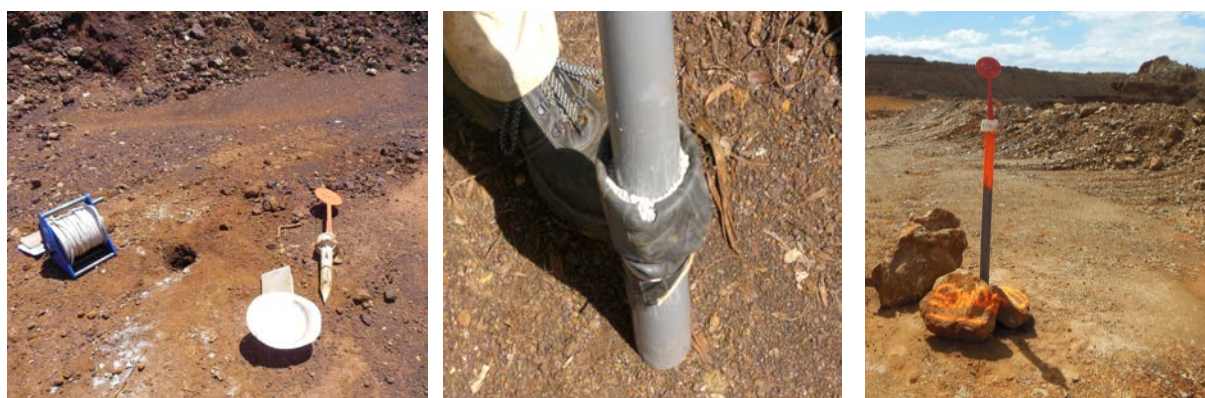
Figure 24 : Installation d'un ouvrage temporaire (Massif de Poro) (source JL. Join)
