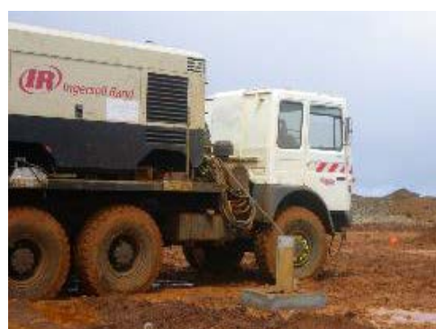
Figure 28 : Développement d'un piézomètre (Massif de Tiébaghi) (source Golder)
