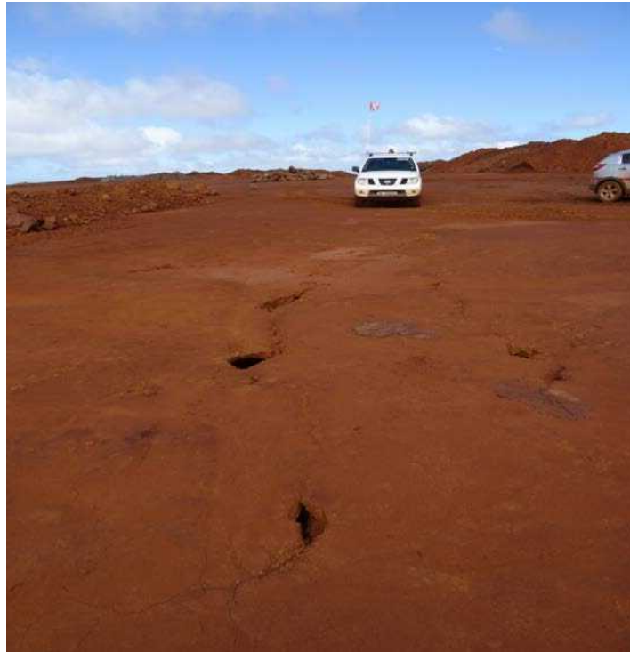
Figure 35 : Instabilités : formation de fissures sur verse (source J. Jeanpert)
