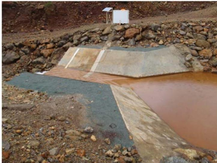
**Description :** Seuil de trapézoidal. Equipé de 2 sondes.
