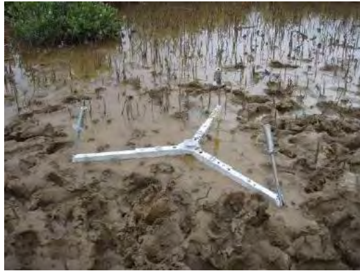
Figure 21 : Mise en place du gabarit de montage sur site
