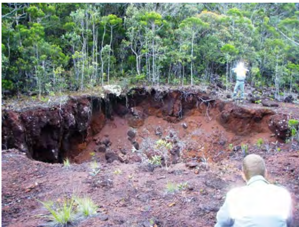
Figure 130 : Effondrement de la cuirasse sur le site de Goro.
