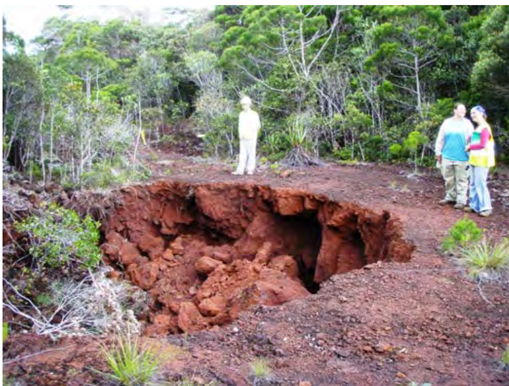
Figure 131 : Effondrement de la cuirasse sur le site de Goro.
