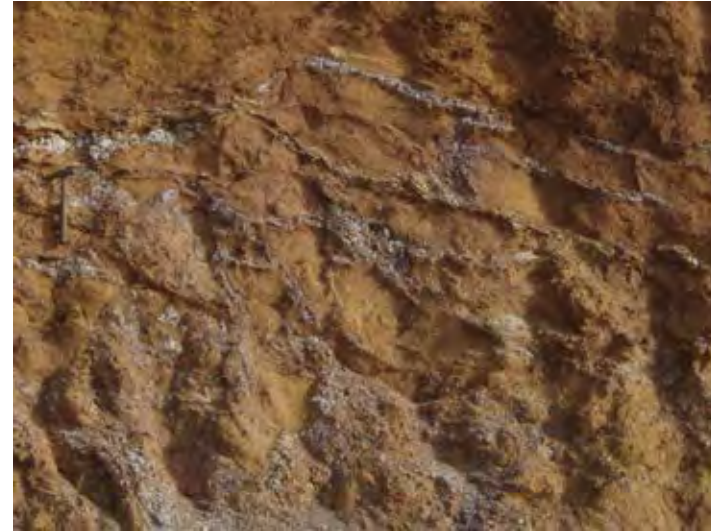
Détail de la photographie précédente (Chantier Bossu).
