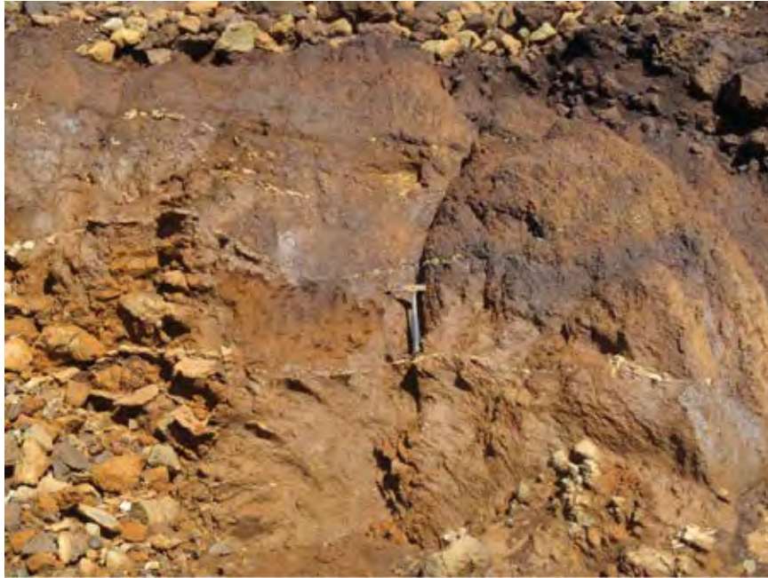
Figure 63 : Massif de Poro, mine La Française, fosse Stanislas. Fractures siliceuses conservées au sein des latérites tendant à s'horizontaliser par compaction.
