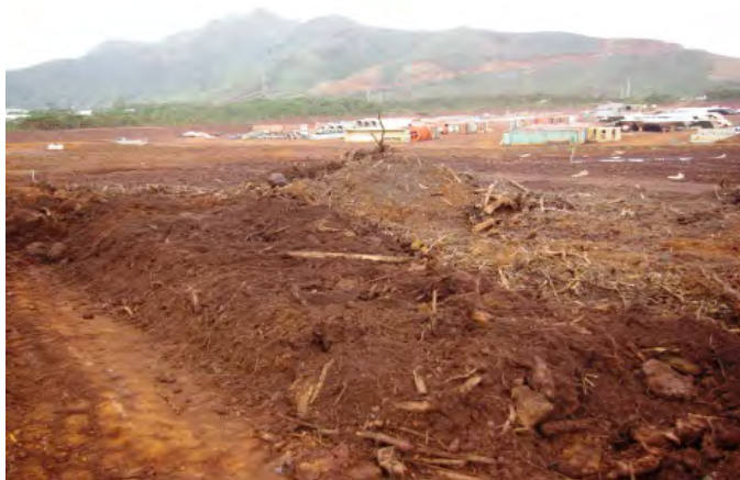
Figure 14 : Topsoil étalé (50 cm d'épaisseur environ)
