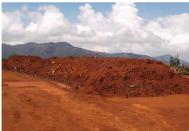
Figure 16 : Andain de topsoil (2 m de haut environ) stocké sur la mine de vulcain à Tontouta (mise en place août 2011).
