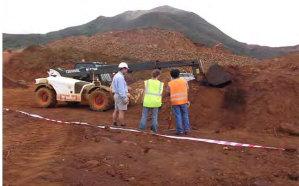
Figure 15 : Mise en place du topsoil stocké en andain sur la mine de vulcain à Tontouta (août 2011)
