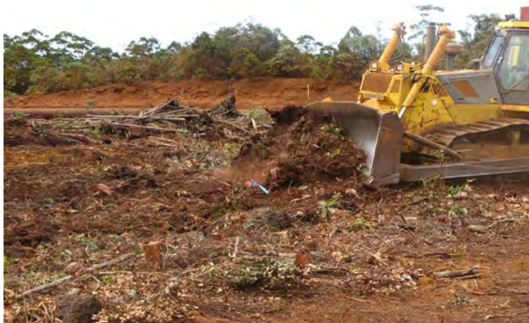
Figure 10 : Récupération du topsoil après décapage
