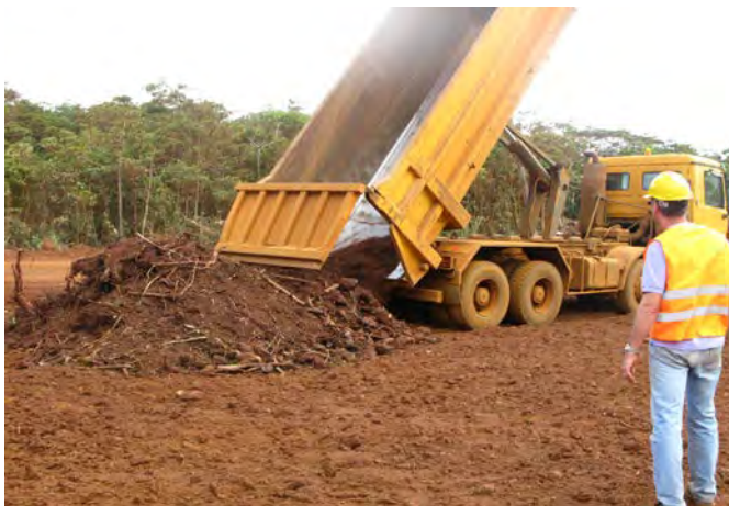
Figure 12 : Déchargement du camion
