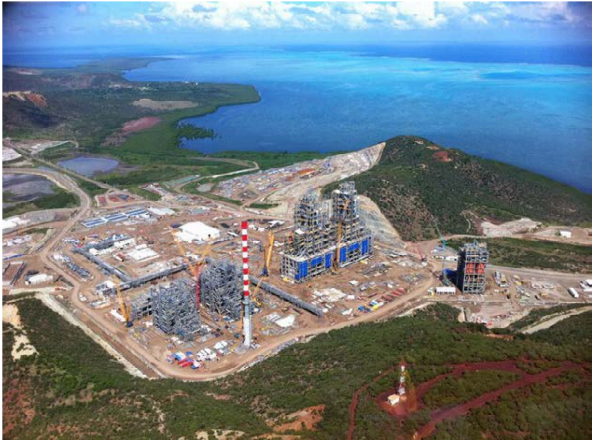
Figure 4 : Le chantier de KNS à Vavouto (source : DIMENC)
