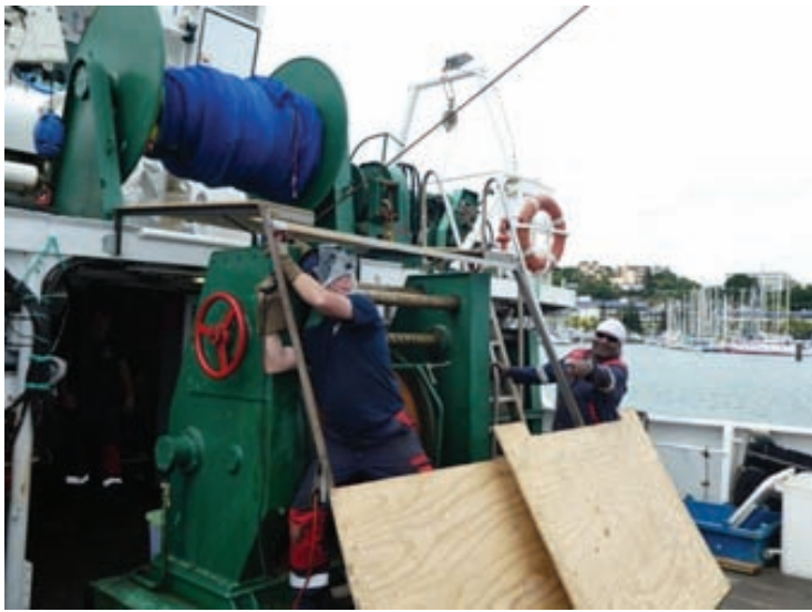
Préparation du coffrage autour du treuil pour le virage du chalut pélagique. Isolating the main winch for pelagic-trawl hauling.
