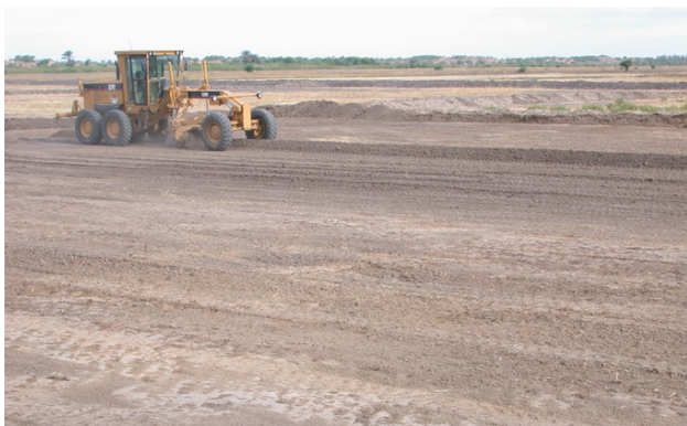
Fig. 15. Réhabilitation de périmètre
